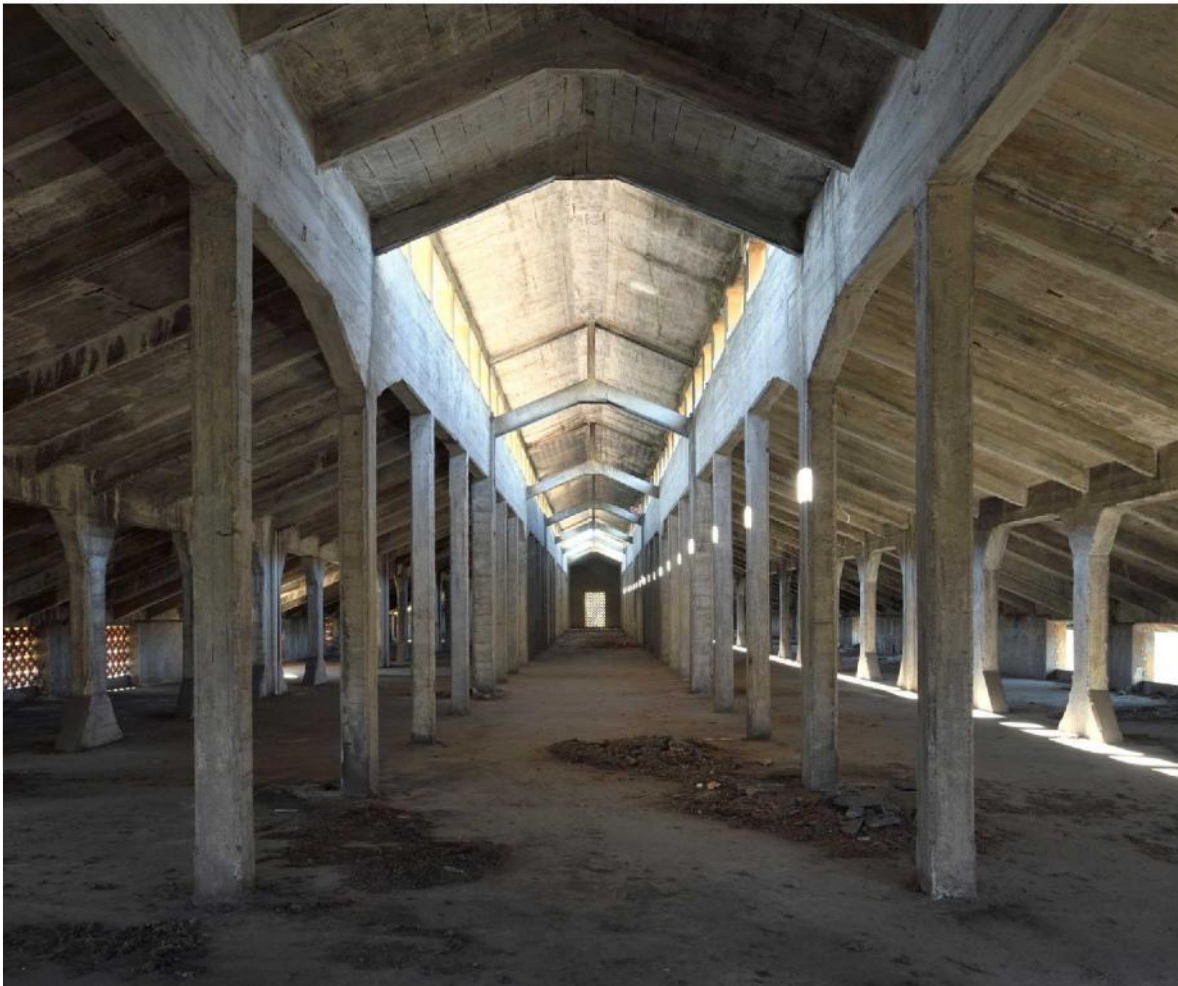
Struttura piano primo dell'ex stalla con solaio sospeso da travi Vierendeel
